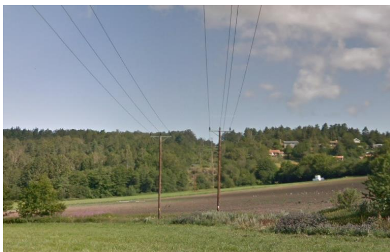
Figur 5. Foto från ledningsträckningen.
