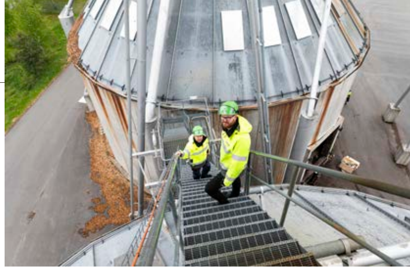
En lucka uppe på toppen av bibränslesilon behöver kontrolleras efter ett fellarm. Många trapp- steg senare hittar Karl felet och åtgärdar direkt.
