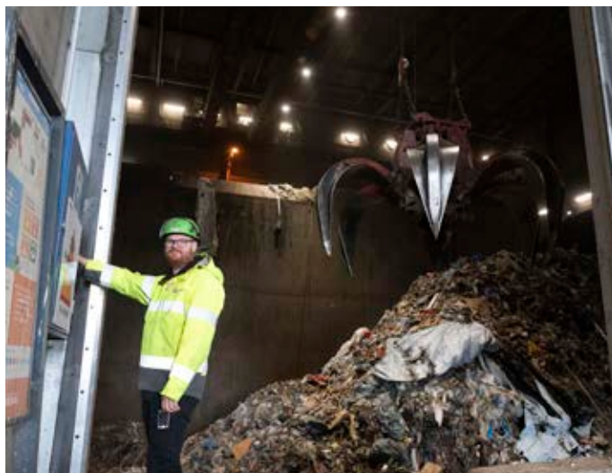
Den avfallseldade pannan matas med våra hushållssopor. Karl rondar och kollar att luckorna där återvinningsbilarna tömmer avfallet fungerar som de ska.
