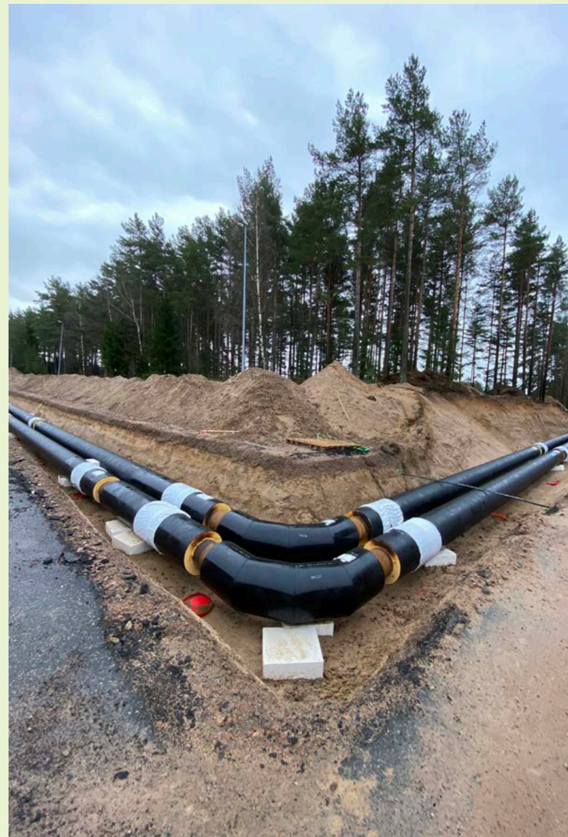
Byggnation av fjärrvärmeledning från Torsvik till Jönköping.
